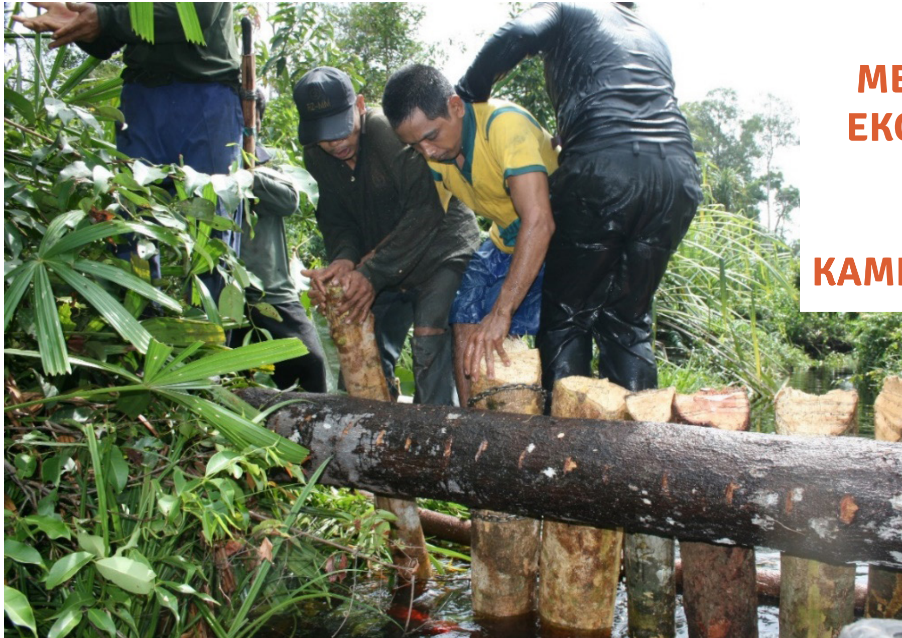
Kegiatan pembangunan sekat kanal di aliran sungai Serkap - YMI
